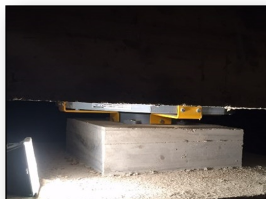
Rimozione dei supporti provvisori Completamento della sottofondazione : collegamento dei plinti
