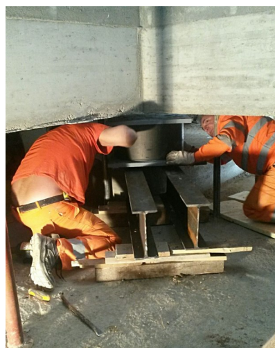
Posizionamento isolatore
