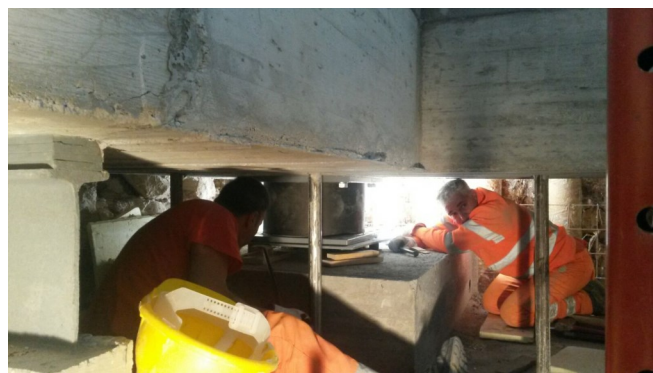
Fissaggio isolatore
